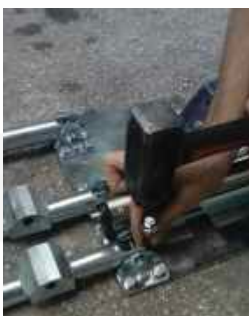
Abbildung 10 - Dübelplatzierung
