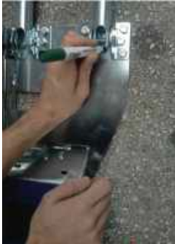
Abbildung 8 - Markieren der Bohrstellen
