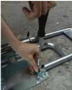
Abbildung 11 - Parkbügel befestigen
